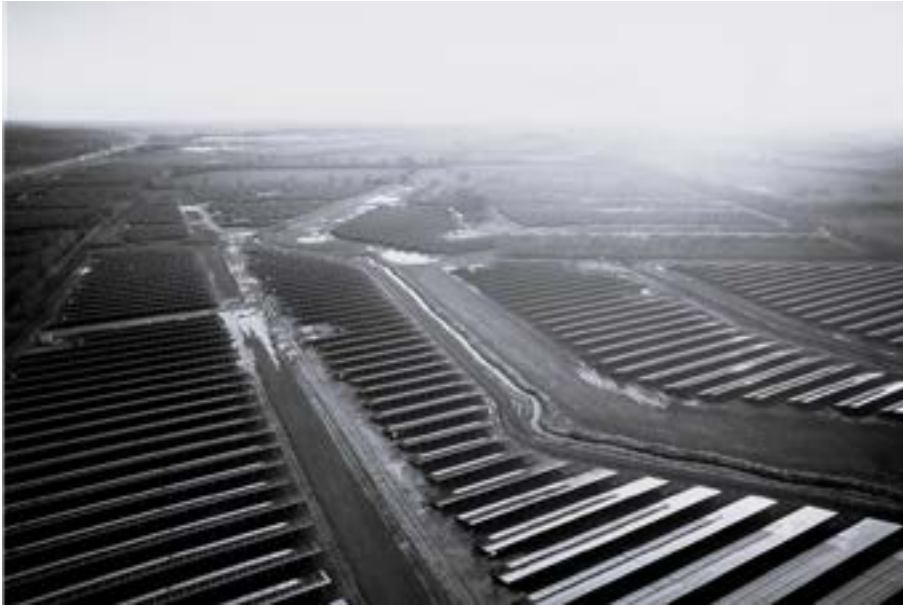
Abbildung 3: PV-Park Wasbek (Quelle: DB AG/Enerparc AG)
